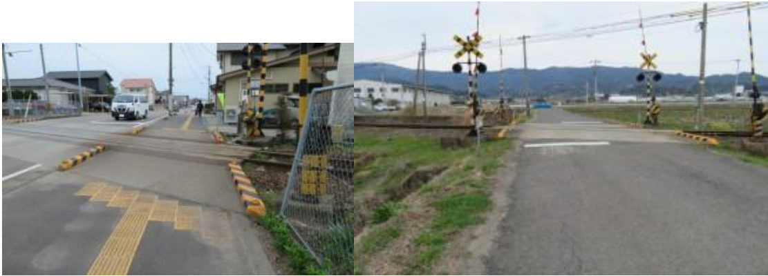
※甘切県道踏切、久米踏切
